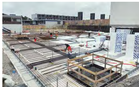
Jord-, kloak- og betonentrepriser
