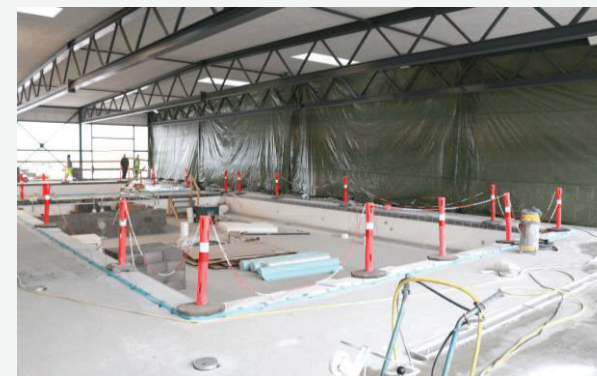
DGI Huset Vordingborg
